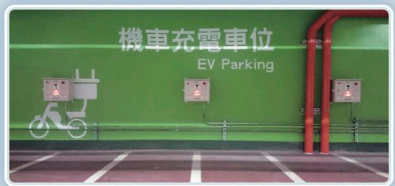
電動機車充電站設置整體情形
